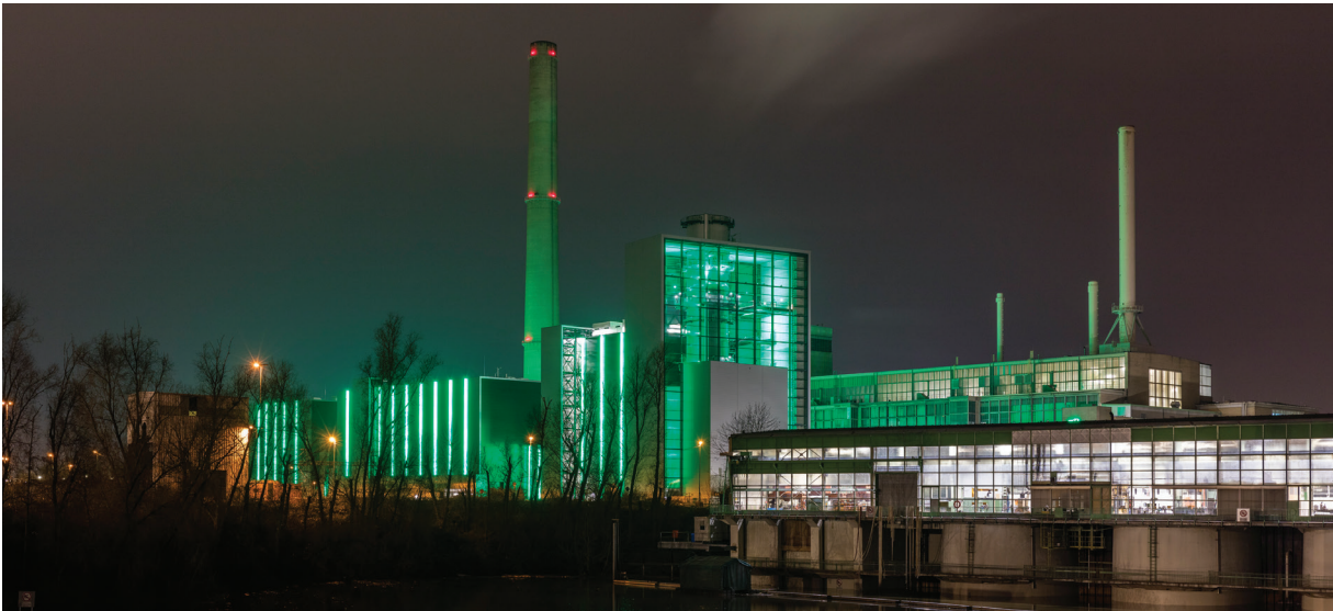
Bild 2: Kraftwerksblock Fortuna der Netzgesellschaft Düsseldorf mbH
